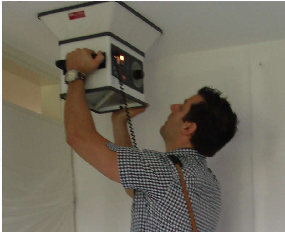
Metten v/d afvoer capaciteit met flowfinder
