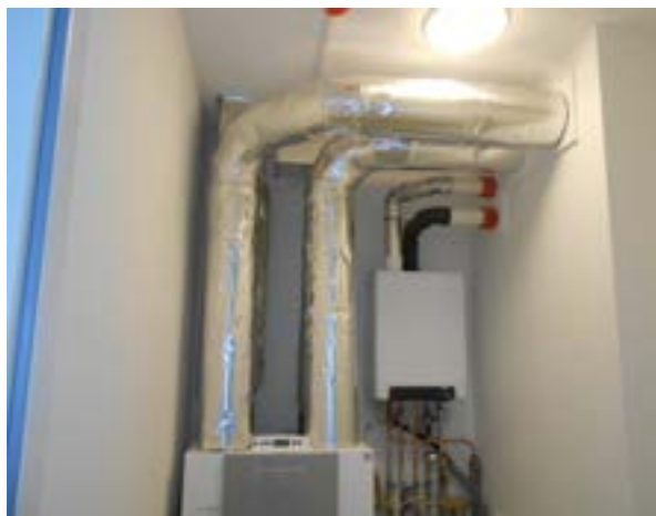
Mechanische afvoer van lucht via een dakdoorvoer en mechanische aanvoer van verse lucht via een opening in de gevel. Het aanvoerpunt zit aan de schaduwzijde van de woning en er kan geen kortsluiting met het afvoerpunt ontstaan.
