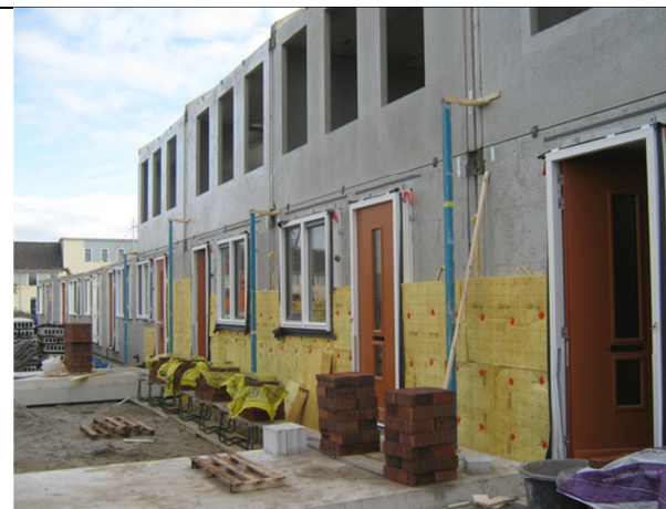
Afb. 3 Overzichtsfoto aanbrengen isolatie
