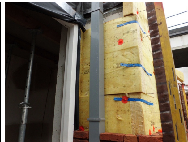
Afb. 6 Goede hoekaansluiting bij isolatiemateriaal
