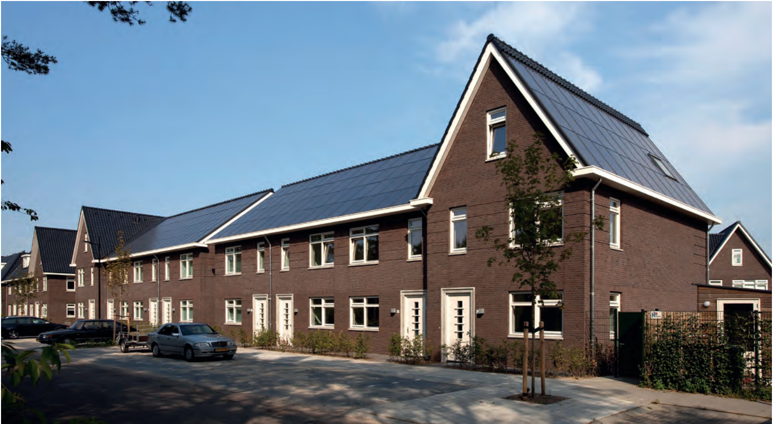
De ideale situatie met de laagste woonlasten: de nulenergiewoning. (foto: VolkerWessels Vastgoed)
