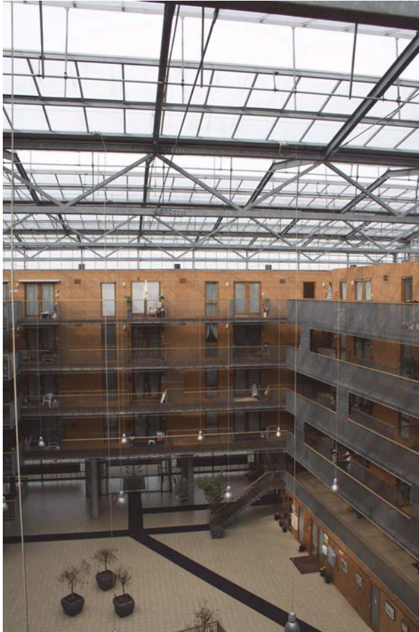
Afb. 4.18 Het Woongebouw Emerald te Delfgauw met honderdenelf woningen, heeft een centraal atrium en is bedoeld voor senioren. De verbreding van de galerijen bij de woningentree nodigt uit tot sociaal contact. Het glazen dak is afkomstig uit de kassenbouw. (Betrokken partijen: Initiatief Woningcorporatie Vestia Delft, architect: Kees Christiaanse Architects & Planners, uitvoering: Bouwcombinatie Delfgauw. Realisatie 2001)
