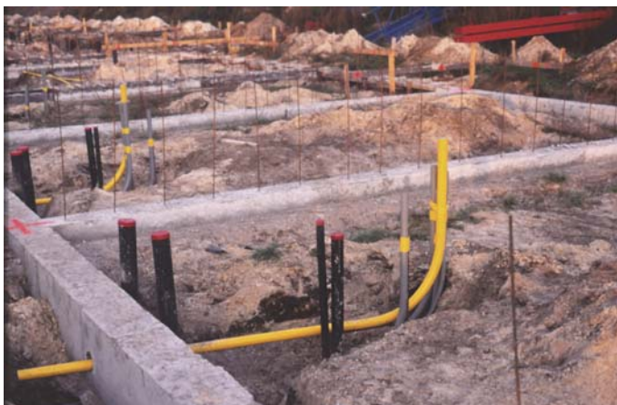
Afb. 5.10 Op tal van nieuwbouwlocaties wordt zonder kruipruimte gebouwd. Op de foto een voorbeeld van bouwen zonder kruipruimte van op de Vindex-locatie Nieuwland in Amersfoort
