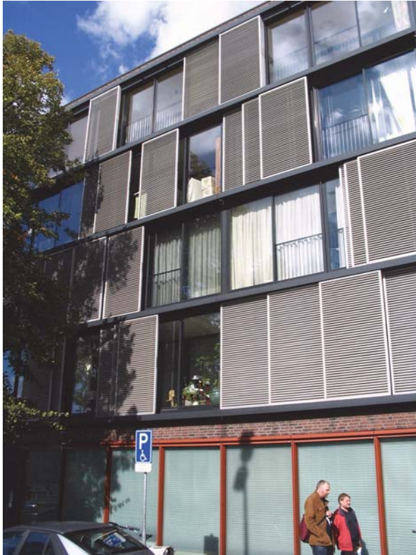
Afb. 4.11 Jaloezielijken of schuifschermen: één van de vele mogelijkheden voor zonwering. De lamellen kunnen zowel vast als draaibaar zijn, afhankelijk van het lameltype en fabricaat. Op de foto het project Delfts Blauw in Delft met luiken opgebouwd uit een frame en lamellen van aluminium; (Betrokken partijen: Limelight; architectenbureau: Architecten Cie en ontwikkelaar Eurowoningen)
