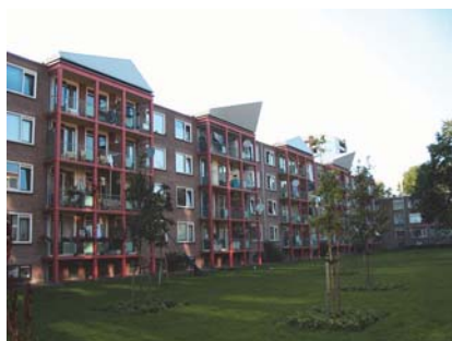
Afb. 7.31 In het 2MW-project in het Haarlemse stadsdeel Schalkwijk wordt bij 382 bestaande flatwoningen door toepassing van verschillende systemen en maatregelen een energiebesparing gehaald van 70%. Een nooit eerder op zo'n grote schaal toegepaste combinatie van zonnecollectoren, warmteopslag in de bodem en warmtepompen vervangt de bestaande verwarmingsinstallatie. De zonnecollectoren zijn in duidelijk zichtbare 'dakkappen' opgenomen. (Betrokken partijen: Opdrachtgevers: Elan Wonen Haarlem, de Woonmaatschappij en Pré Wonen; energiesysteem: Eneco; adviseur: BOOM-SI en DWA)
