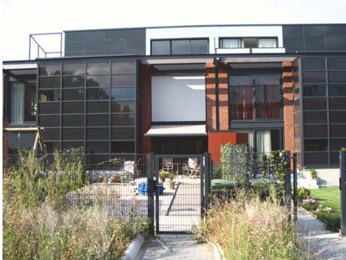
Afb. 5.35 Voorbeeld van een project waarbij de beweegbare zonwering bij de koopprijs inbegrepen was. Een deel van de gevel is voorzien van doorzicht-PV-panelen, ook een vorm van zonwering. De woningen liggen in De Energiewijk in Roomburg te Leiden. (Betrokken partijen: Planontwikkeling: Gemeente Leiden; Architect: Han van Zwieten Architecten bna; Ontwikkelaar/aannemer: ACL; Aannemingscombinatie Leiderdorp; Realisatie 2004)
