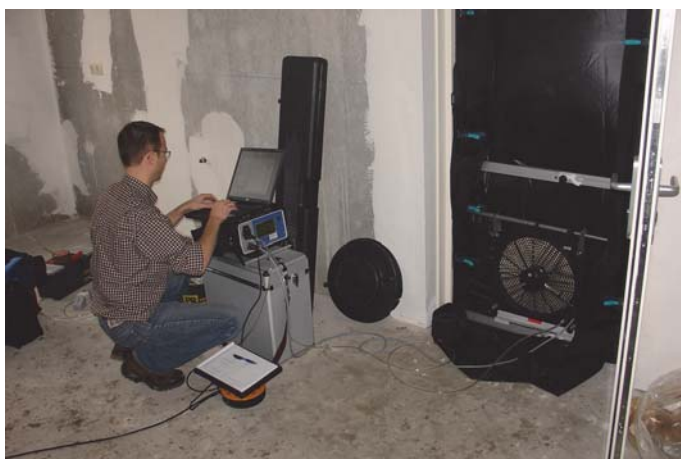
Afb. 5.2 Luchtdichtheidsmeting met behulp van een tijdelijk aangebrachte 'blowerdoor'. Met behulp van rookdetectie kunnen luchtlekken zichtbaar worden gemaakt. (Bron: Nieman Raadgevende Ingenieurs)
