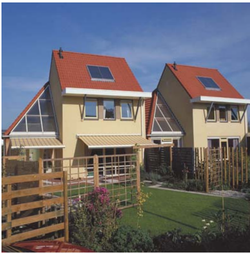
Afb. 9.13 Een vlakkeplaatcollector onder en vacuümbuiscollector boven. (Bron: Redenko/ZEN)
