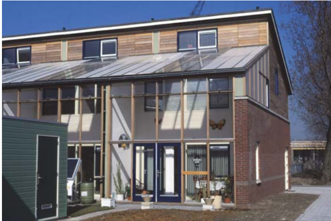
Afb. 4.17 Serres bij huurwoningen in Banne-Oost in Amsterdam-Noord. Het dak van de serre is deels voorzien van (doorzichtige) beglazing in verband met daglichttoetreding. Op het dak zijn ook zonnecollectoren aangebracht. (Betrokken partijen: ontwerp: Tjerk Reijenga, voorheen BEAR Architecten, Gouda. Realisatie: 1995)
