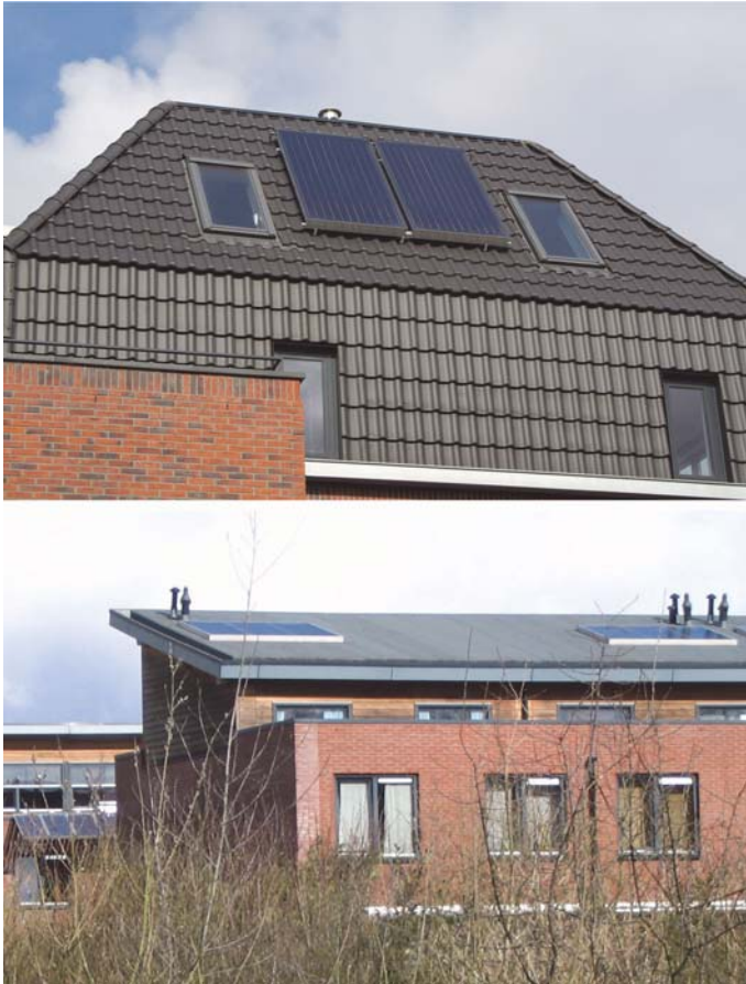
Afb. 9.20 Verschillende voorbeelden van individuele zonneboilers, in Delft (boven) en Boxtel (de Zonnegolven, (Betrokken partijen: architect: Tjerk Reijenga, HBG))
