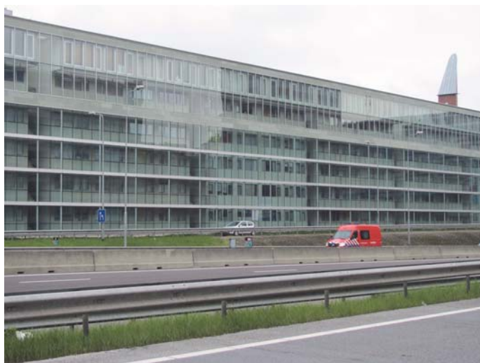
Afb. 4.16 Renovatie en nieuwbouwproject De Leeuw van Vlaanderen met 72 huurwoningen voorzien van nieuwe vliesgevel als geluidbuffer. Om geluid en stank van het verkeer op de A10 (Amsterdam) te weren is de vliesgevel geplaatst voor de bestaande oostgevel. De ruimte achter deze vliesgevel dient voor de ontsluiting van de woningen en wordt geventileerd met schone buitenlucht afkomstig van de westgevel. Vanwege de brandveiligheid is de verglaasde ruimte voorzien van een stuwkrachtventilatie om bij brand rook te verspreiden en te verdunnen (Betrokken partijen: Nieman Raadgevende Ingenieurs, opdrachtgever: Far West, architect Heren 5 architecten, aannemer Coen Hagedoorn, realisatie 2005)
