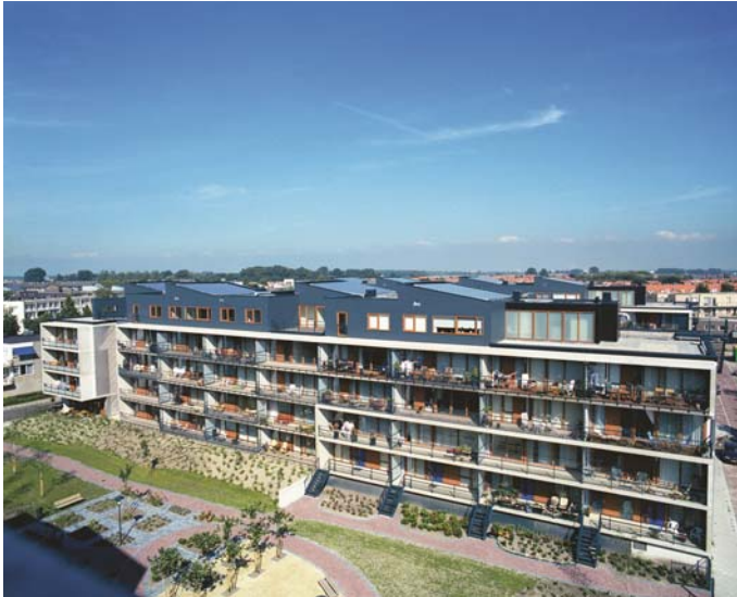
Afb. 9.22 Een collectief zonneboilersysteem op appartementencomplex Charivarius te Haarlem. Een project van Eco Energy en Pré Wonen Haarlem; (Betrokken partijen: aannemer: Panagro; architect: HMADP groep; adviseur: BOOM-S/I; Realisatie 2005; Eneco)
