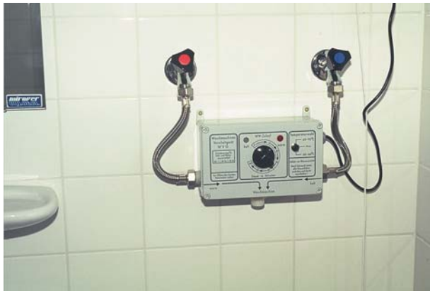
Afb. 9.5 Voorschakelkastje bij hot-fillaansluiting voor een standaard wasmachine
