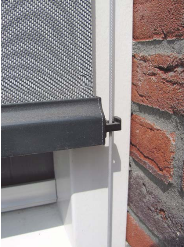
Afb. 4.13 Zorg er voor dat de spouw tussen screen en raam geventileerd is. Dit kan door een zijgeleiding van roestvrije staalkabel toe te passen
