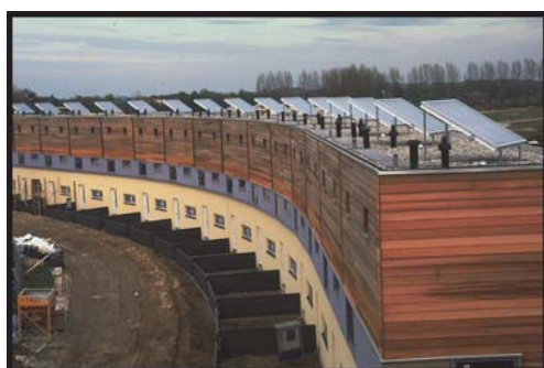
Afb. 4.3 Woningen met zonnecollectoren op platte daken in Nieuwland, Amersfoort. Alle collectoren zijn op het zuiden gericht ondanks de wisselende oriëntatie van de woningen. (Bron: ontwerp: Olga Architecten)
