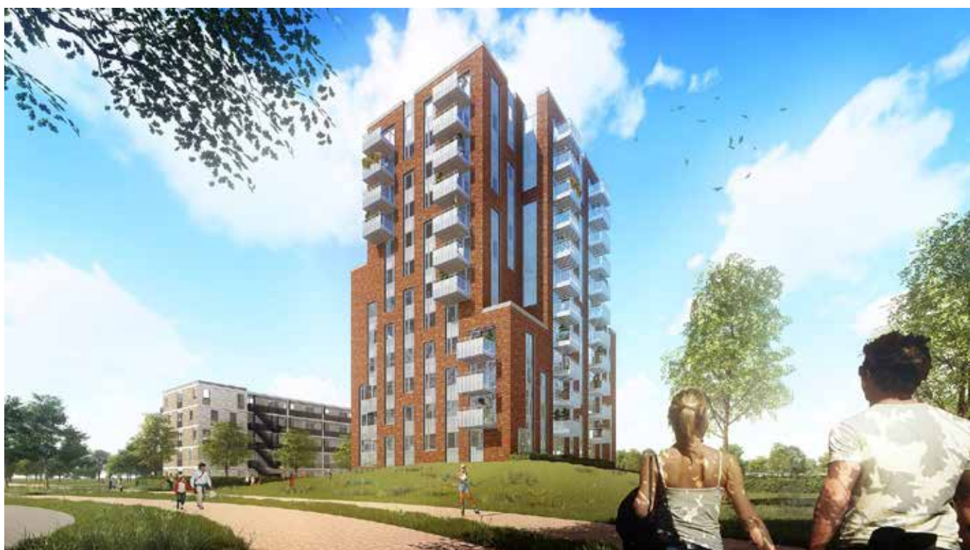
Woongebouw Madrona in Almere. Het gebouw met 95 appartementen volgens het concept zes-spanner wordt in opdracht van GoedeStede door Trebbe gebouwd. De woningen zijn voorbereid op all-electric.
