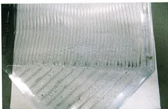
4. Onderzijde toevoer (swab-monster 8), aan de achterzijde is condens zichtbaar.
