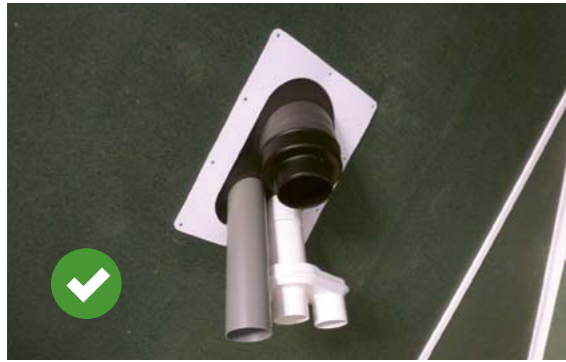
De dakdoorvoeren luchtdicht afgewerkt met een manchet.
