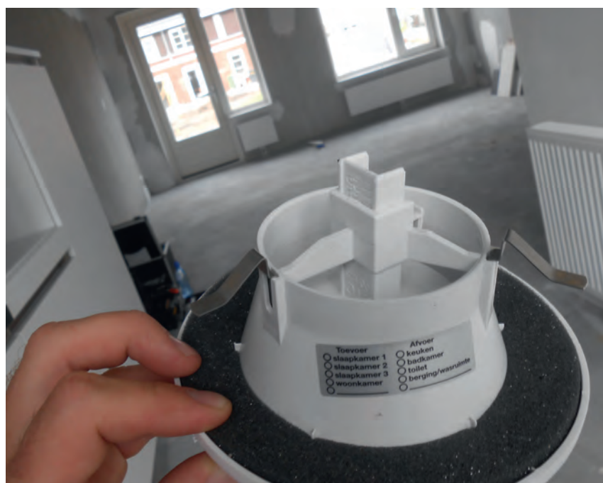
Inregelen van ventielen zorgt ook voor weerstand in het systeem. Verdelen van de toevoer is een alternatief.
