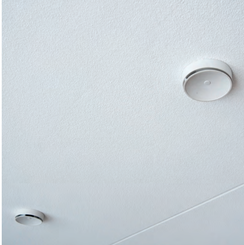
Balansventilatie met wtw is een effectieve manier van ventileren. "Verse lucht komt op de plek waar je bent als mens, en dat weet je zeker."
