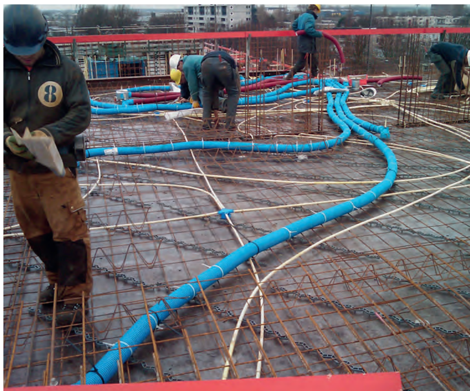
Bij gebruik van een tunnelkist is er volop ruimte voor kanalen, die in ruime bochten kunnen worden gelegd en daarmee niet of nauwelijks voor weerstand zorgen.
