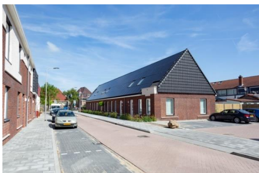
34 NOM-woningen aan de Siemensstraat te Leerdam. Opdrachtgever woningcorporatie KleurrijkWonen. Opgeleverd in 2018. De EPV is voornamelijk op € 0,- gesteld. De corporatie wil eerst zien wat de woningen doen. Bij mutatie kan overwogen worden om wel EPV te heffen.
