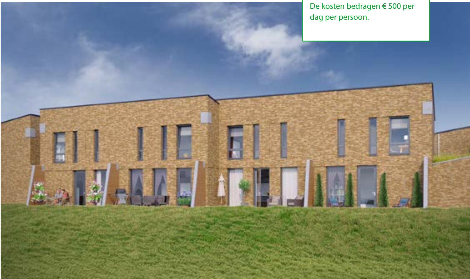
Zwolle, 22 Nul-op-de-meter woningen volgens het concept HuisvanU. Opdrachtgever: SWZ. Realisatie: Plegt-Vos. De woningen zijn nu in aanbouw. De 'all electric' woningen worden met ventilatielucht verwarmd en hebben geen vloerverwarming of warmtepomp. De PV panelen zijn in het dak geïntegreerd.
