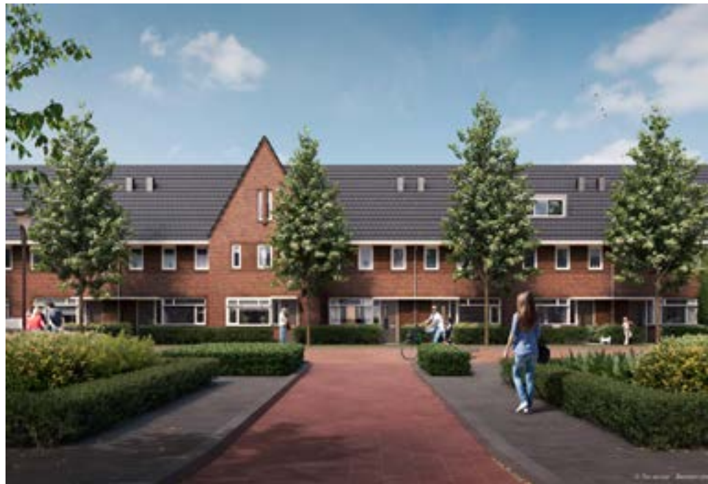
Wageningen, 249 woningen in Tuinwijk, Nieuw Kortenoord. De woningen (EPC 0,4) hebben een individuele modulerende bodemwarmtepomp, vloerverwarming en passieve koeling met naregeling per vertrek, douchewtw en mechanische ventilatie op basis van CO 2 - en vochtsturing. In basis geen PV-panelen, wel als kopersoptie. Ontwikkelaar: BPD. Realisatie: Trebbe Wonen (concept: BasisWonen). De derde fase is nu in aanbouw.
